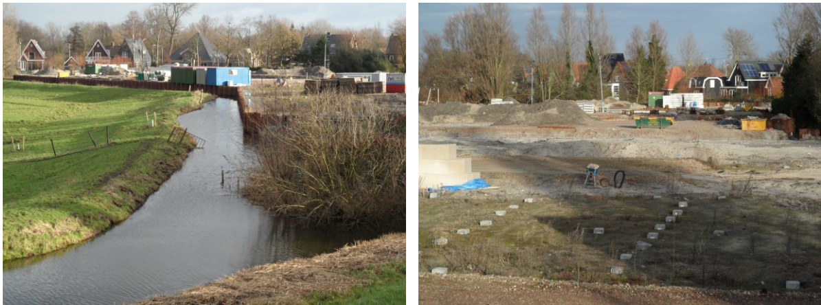
Figuur 2.2 Links: nieuwe damwand rond het voormalig bedrijfsterrein Kiekens, rechts: bouwactiviteit op het terrein
